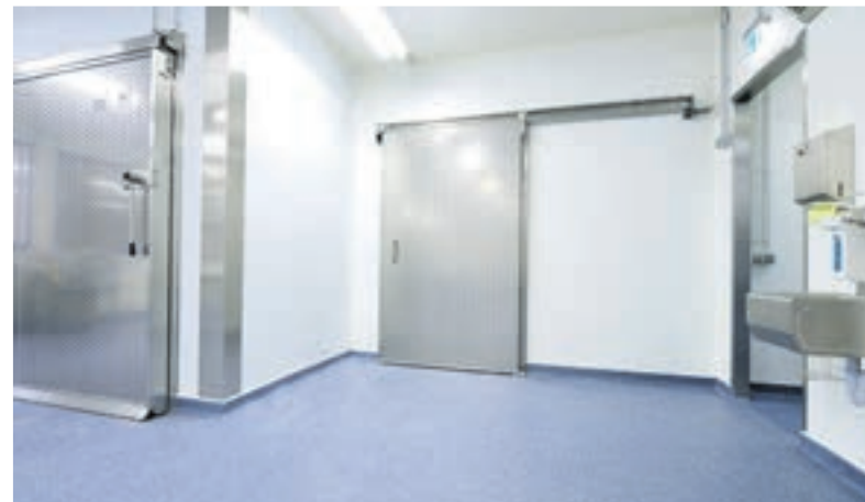
Reaktionsharz-Böden mit eingestreuten Colorquarzen sorgen auch in Lagerräumen für eine optimale Trittsicherheit der Mitarbeiter. Foto: Silikal
