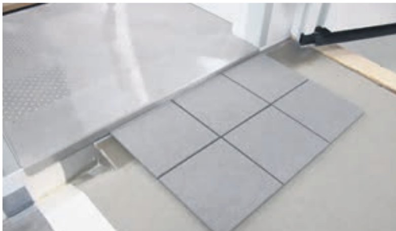
Besonders kritisch: Abdichtungsfugen rund um die Rinnen an Übergängen zu Türen und Kühlzellen. Foto: Sopro
